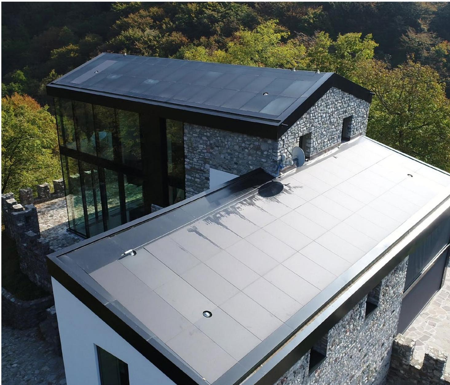
Castello di Doragno, Rovio, impinato fotovoltaico e impianto solare termico integrati in copertura. deltaZERO. Foto: L. Carugo.
