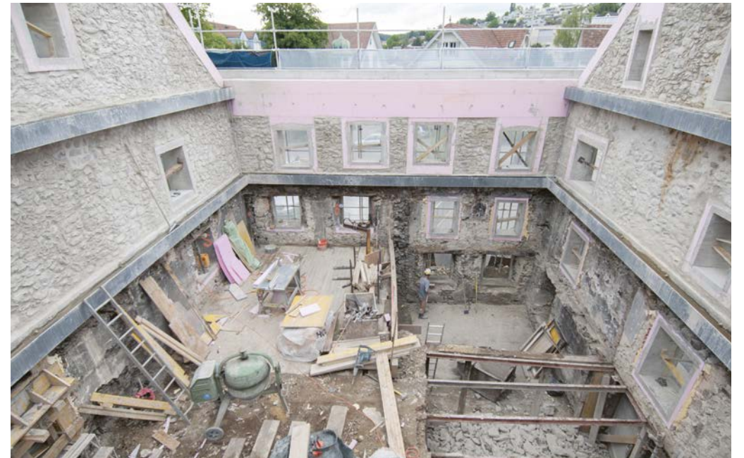
Baustelle Schlössli 2016 und 2017. Fotos: Fabian Furter.
