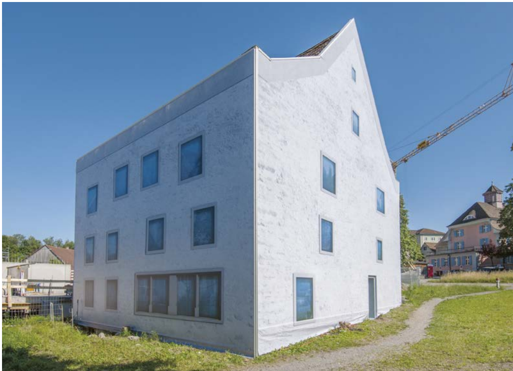
Im Sommer 2015 werden an der Nord- und an der Westfassade bedruckte Blachen appliziert, welche das neue Renovationsprojekt im Massstab 1:1 visualisieren. Fassadenvisualisierung: Joe Rohrer. Fotos: Fabian Furter.
