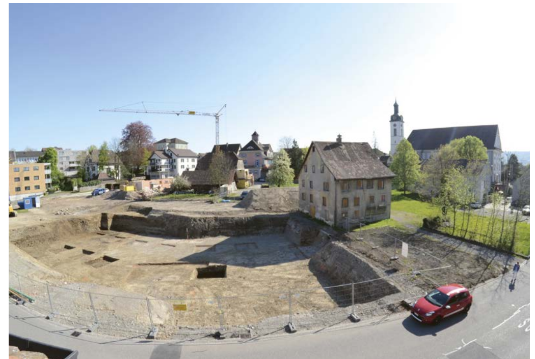
Umgebung während den Aushubarbeiten für die benachbarte Überbauung. Aufgenommen mit einem Fischaugen-Objektiv 2015. Foto: Dani Müller.
