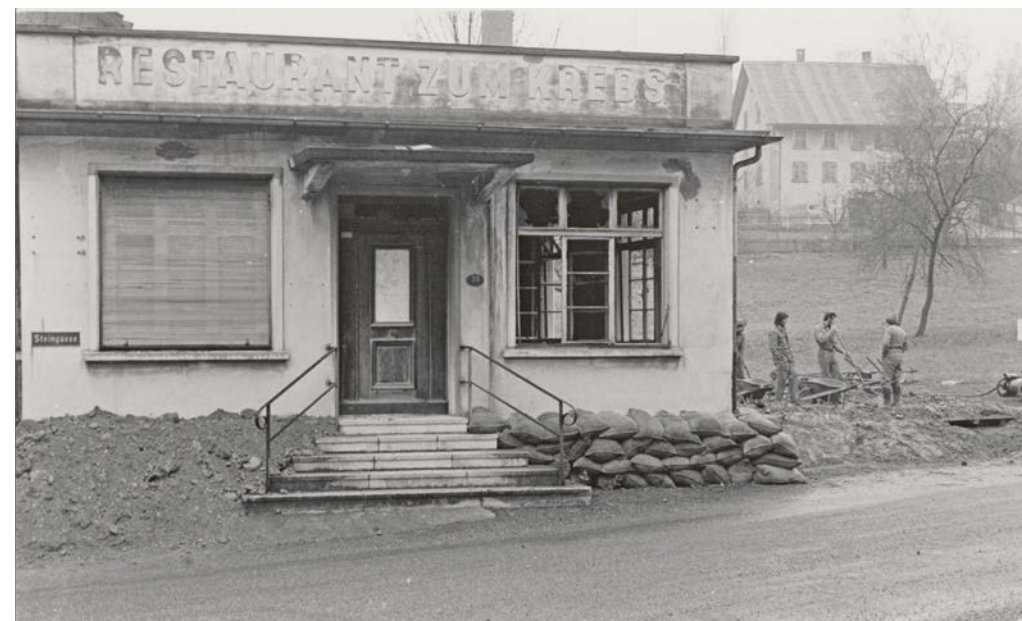
Abbruch ehemaliges Restaurant Krebs an der Kreuzung Steingasse-Talbisgässchen. Im Hintergrund das Seckelmeisterhaus. Foto: undatiert, 1970er-Jahre, Archiv Wohler Anzeiger.
