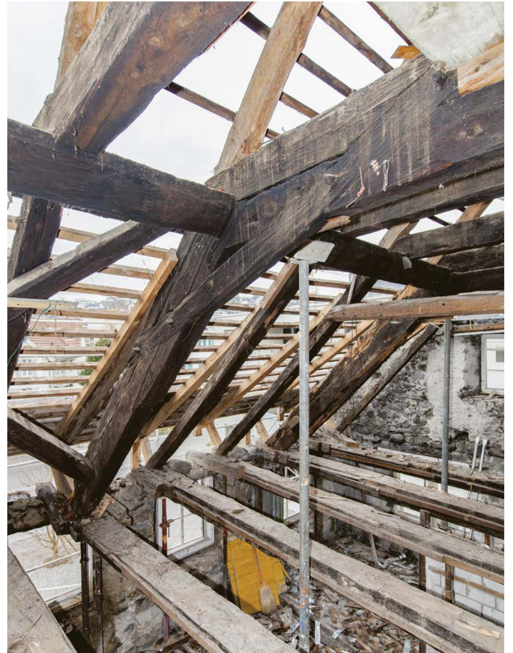
07 Dachstuhl-Bund mit Kopfstrebe. Mittleres 16. Jahrhundert. Foto: Kantonsarchäologie Aargau, Th. Frey.
