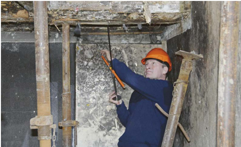
Felix Walder, Dendrochronologe vom Amt für Städtebau der Stadt Zürich entnimmt im November 2016 einem Deckenbalken eine Kernbohrung zwecks Datierung der Hölzer. Foto: Wohler Anzeiger, Daniel Marti, 2016.
