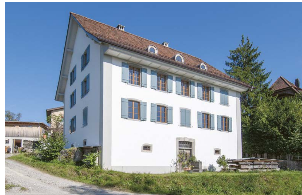
Das denkmalgerecht renovierte Seckelmeisterhaus an der Steingasse 47. Foto: Fabian Furter 2021.
