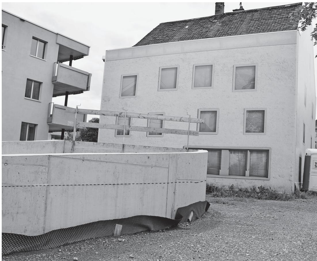
Klare Verbesserung angestrebt: Die betonierte Einfahrt in die Tiefgarage wird teilweise zurückgebaut. Die Höhe der Mauern wird (bis zum Strich) verringert.
