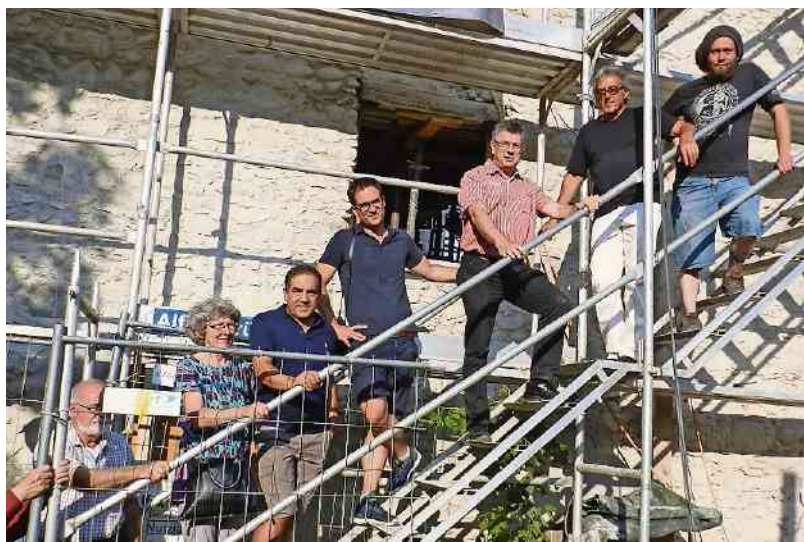
Die Vereinsmitglieder mit Präsident Fabian Furter (Bildmitte) und Architekt Hans Furter (Zweiter von rechts) besichtigten die Schlössli-Baustelle.
